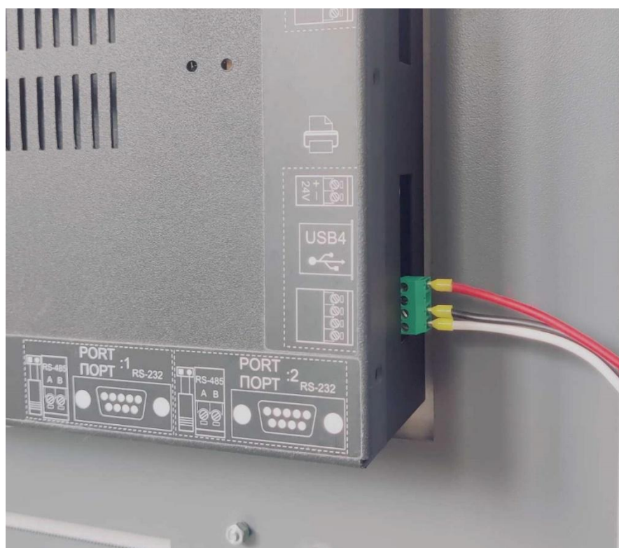
Rys. 5.6 Podłączenia złącza 4-pinowego do centrali POLON 6000 (PSO-60)
