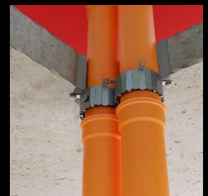
KOŁNIERZE NA RURACH PROWADZONYCH BLISKO SIEBIE
