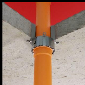
MONTAŻ KOŁNIERZA NA MUFIE RURY PALNEJ
